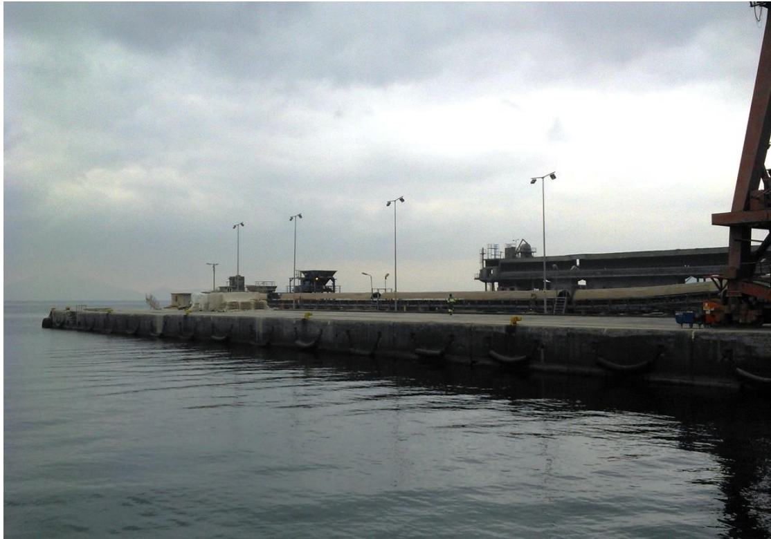
Φωτογραφία 1: Προβλήτας Γ' της λιμενικής εγκατάστασης του εργοστασίου της Α.Γ.Ε.Τ. Ηρακλής Βόλου.
